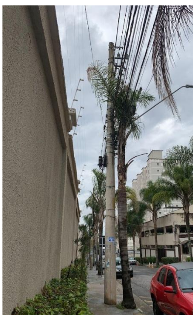
Errado: palmeira plantada sob rede elétrica, muito próximo à infraestrutura urbana e com pouco espaço permeável para as raízes.
