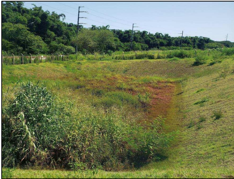
Figura 13 - Exemplo de bacia de amortecimento/infiltração. Fonte: PREFEITURA MUNICIPAL DE CAMPO GRANDE, MS.
