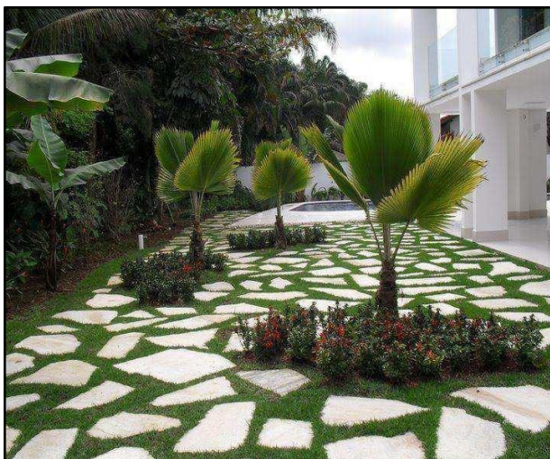
Figura 25 - Exemplo de pavimento de elemento vazado com vegetação. Fonte: PRIETO, 2012.
