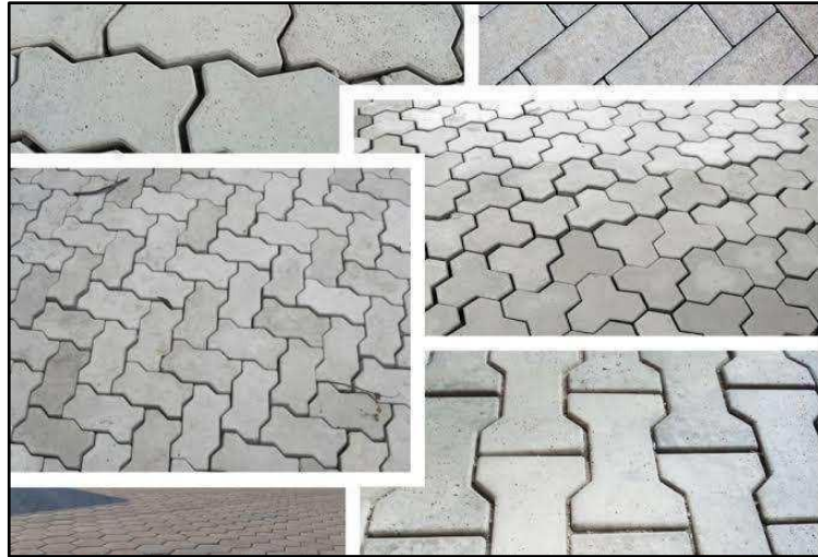
Figura 26 - Exemplos de pavimento modular. Fonte: INOVA CONCRETO, 2018.
