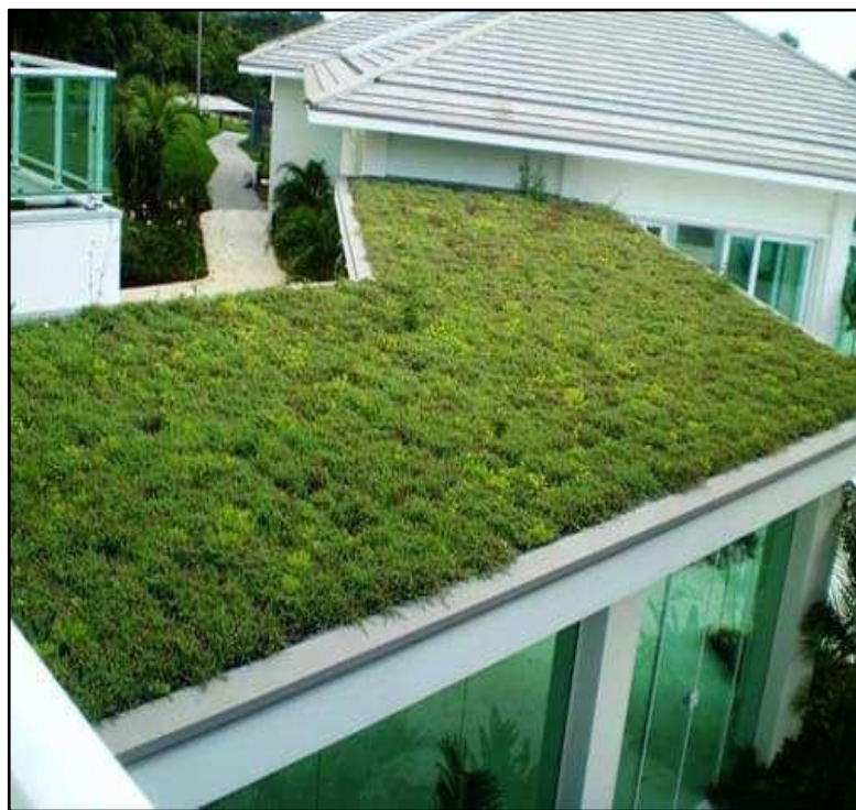
Figura 32 - Exemplo de telhado verde extensivo. Fonte: AECWEB [201-].
