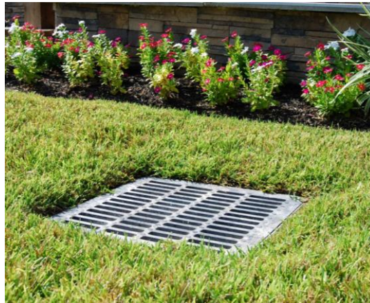
Figura 30 - Exemplo de extravasador (grelha/ralo) da drenagem. Fonte: NW LANDSCAPE MANAGEMENT, 2022.
