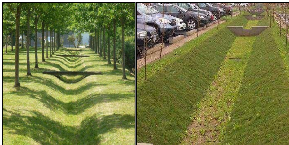
Figura 14 - Exemplo de vala de amortecimento/infiltração. Fonte: Adaptado de ATELIER DE PAYSAGENS BRUEL DELMAR, [20--].
