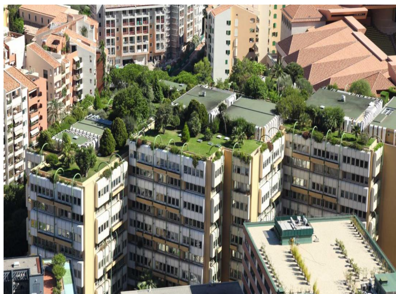
Figura 33 - Exemplo de um telhado verde do tipo intensivo. Fonte: ROCA BRASIL CERAMICA, 2021.
