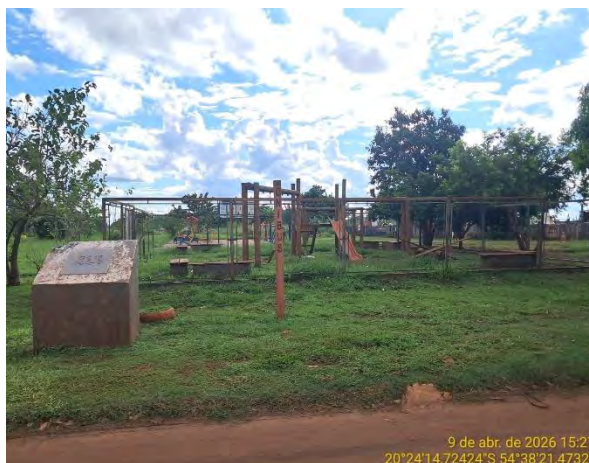
Praça do Bom Retiro – Parquinho na Rua Dulcimar Martins Galvão
