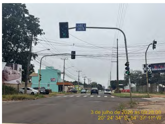
Avenida Tamandaré esquina com Rua Santo Acúrsio
