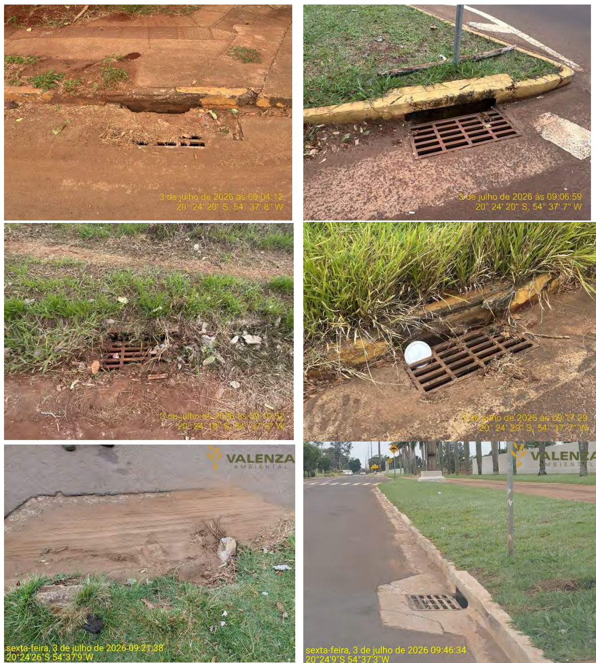
Figura 30 – Sistema de drenagem urbana no entorno do empreendimento ao longo da Avenida Tamandaré
