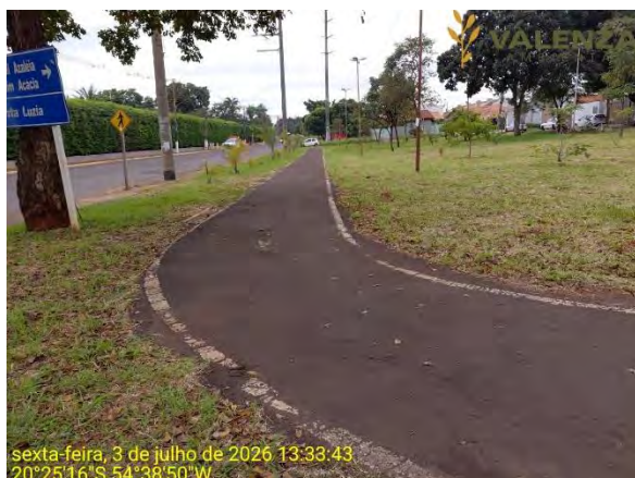
Praça da Azaleia – Pista de Caminhada na Rua Dr. Miguel Vieira Ferreira
