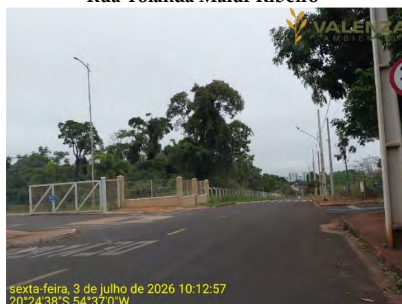
Rua Mal. Câmara
