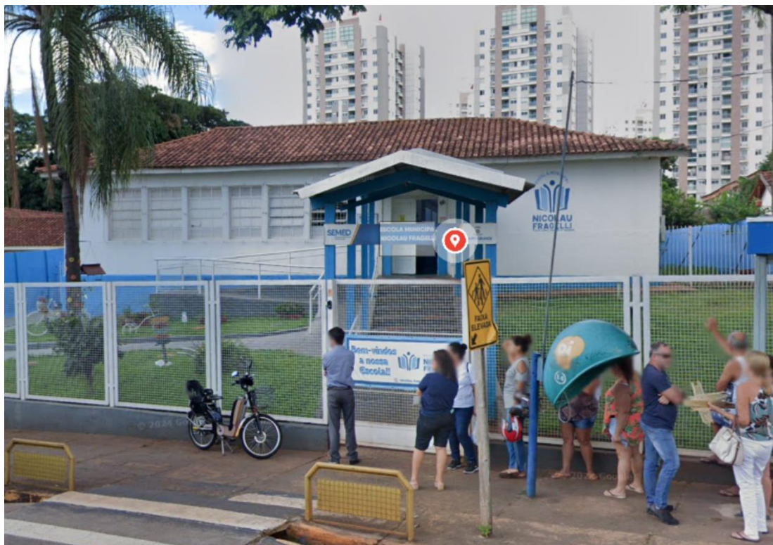
Figura 24 – Escola Municipal Nicolau Fragelli - Fonte: Google Earth, abr/2023.
