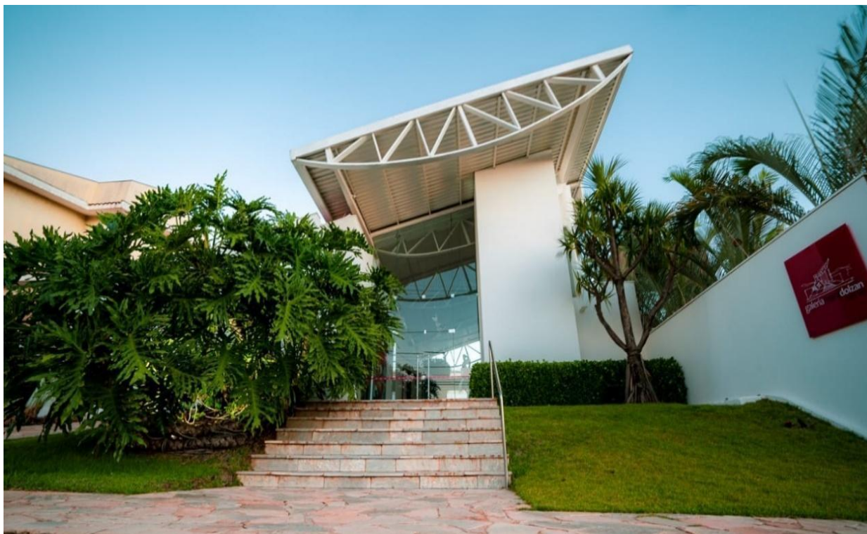
Figura 57 – Galeria Mara Dolzan
