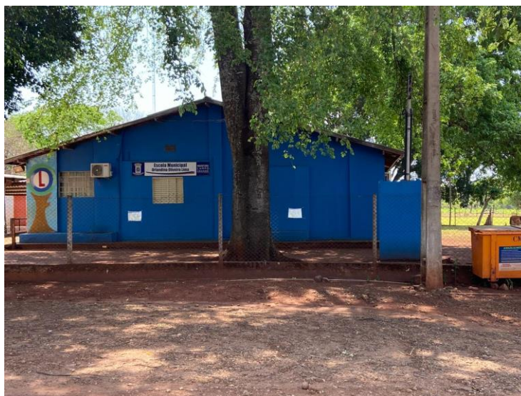
Figura 103 - Escola Municipal Orlandina Oliveira Lima na comunidade Rizolândia
