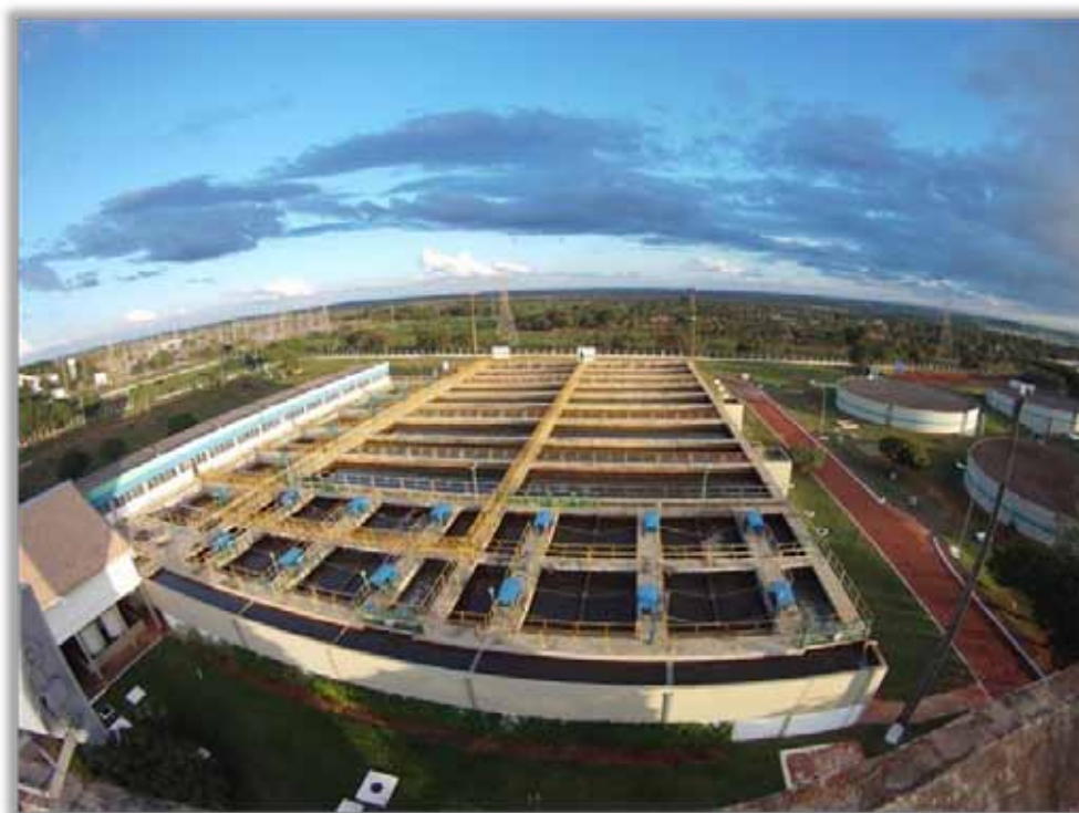
Foto 4 – Estação de Tratamento de água do sistema Guariroba.
