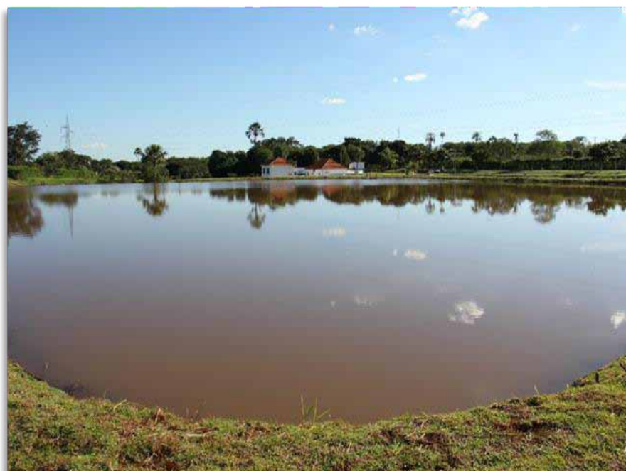
Foto 2 – Reservatório do Córrego Lageado.
