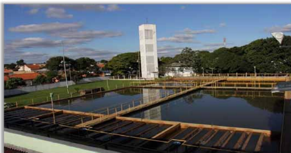
Foto 5 – Estação de Tratamento de água do sistema Lageado.
