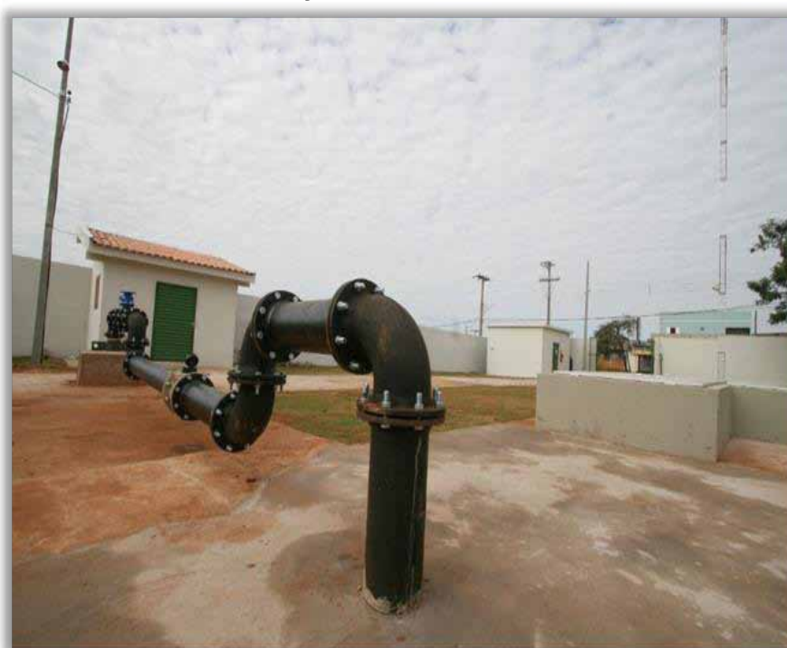
Foto 3 – Poço Especial Novos Estados
