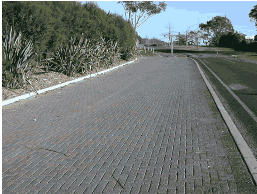
(c) Exemplo de pavimento permeável
