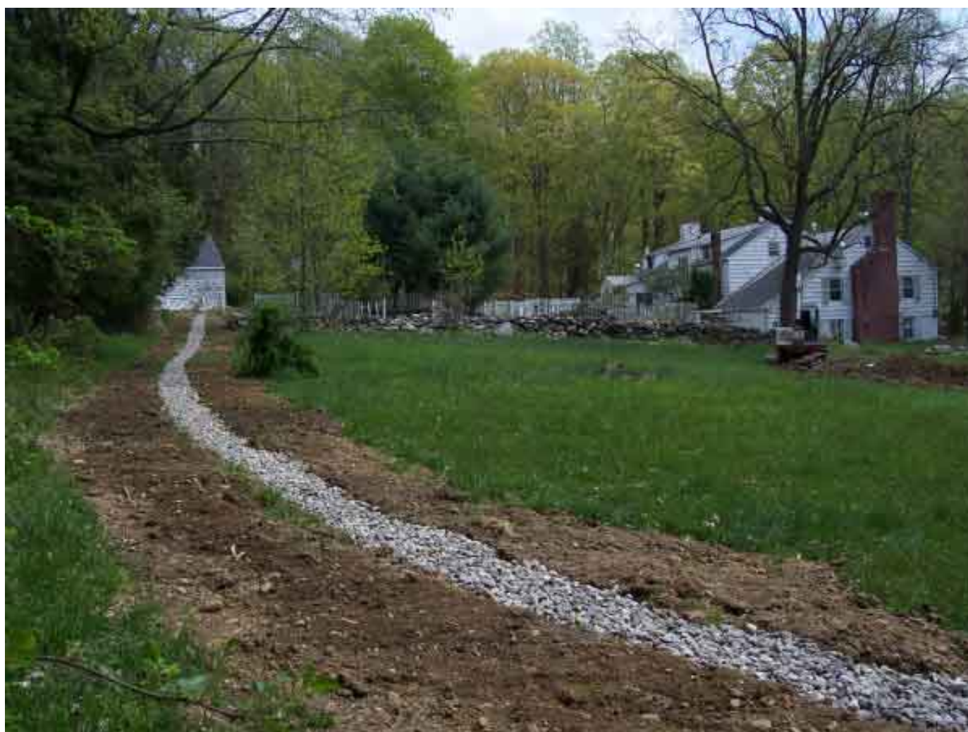
Figura 1.11 – Trincheira de infiltração (CIRIA, 1996).
