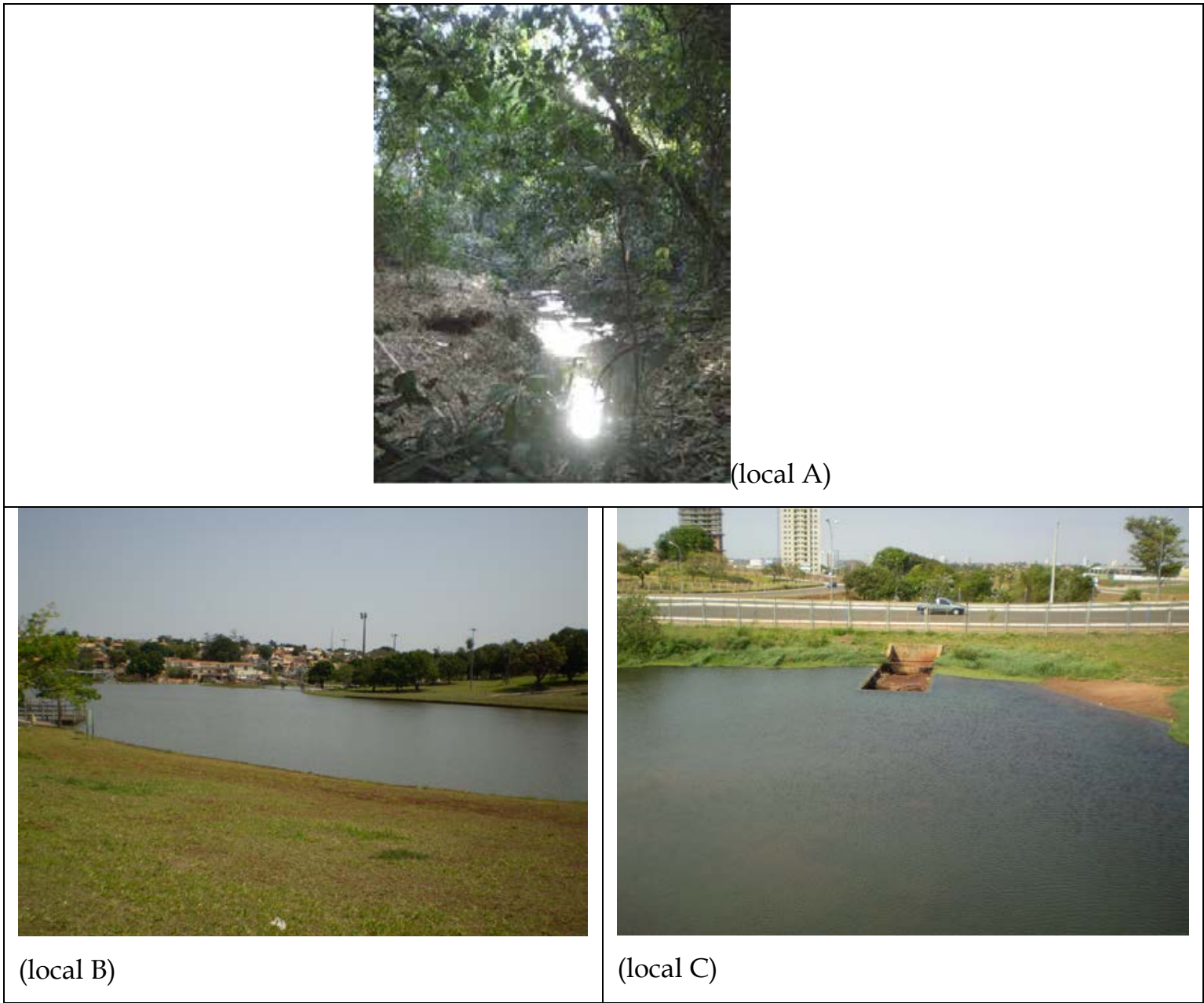
Figura 4.24 – Fotografias mostrando as áreas onde poderão ser instalados reservatórios de retenção on-line .
